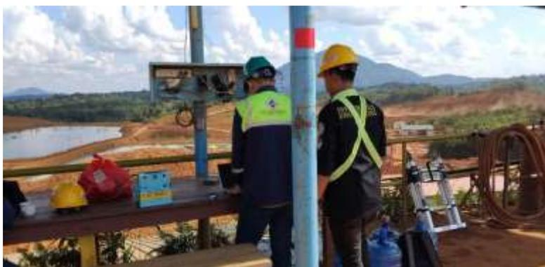
Gambar 3. Pemasangan Router UBNT UBIQUILITY di Bukit 30
